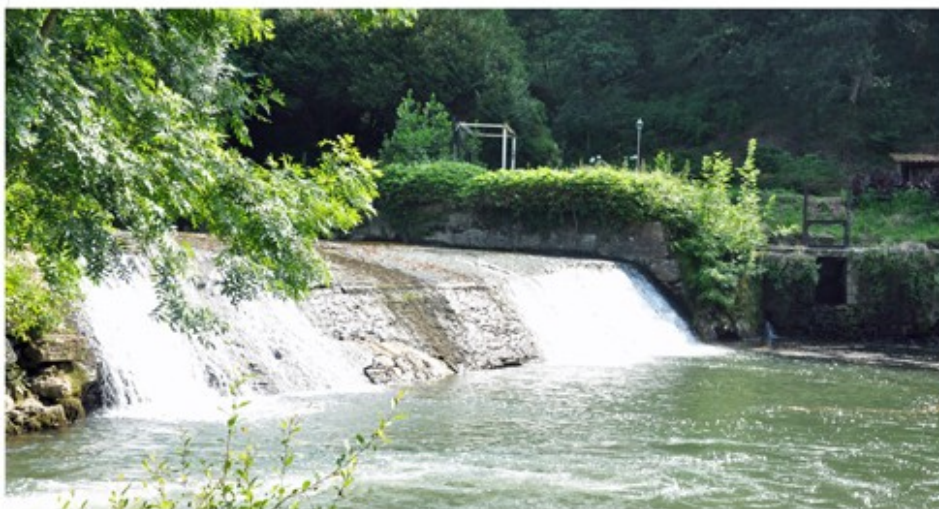
Prise d'eau et canal de dérivation
