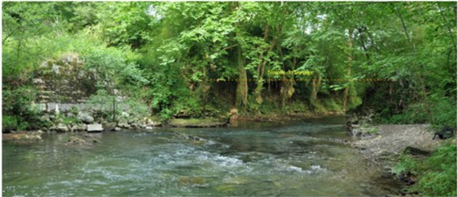
Restes du barrage
