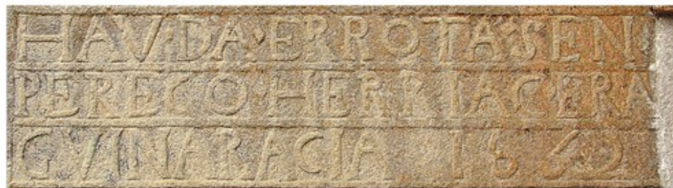
Linteau de la porte d'entrée du moulin
