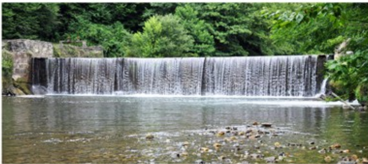
Barrage et prise d'eau du moulin
