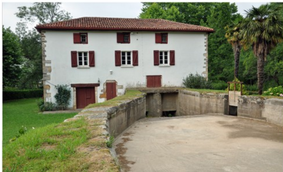
Bassin de rétention et avaloire
