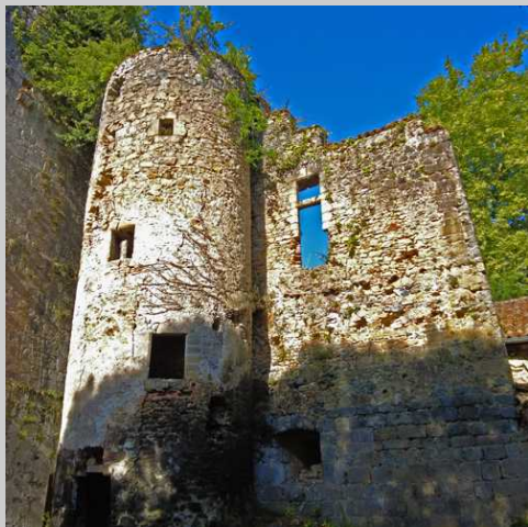
Tour ronde d'escalier permettant l'accès aux différents étages
