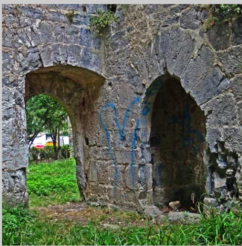
Entrée dans la partie Nord
